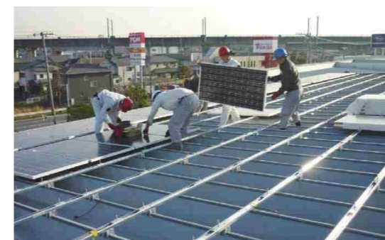
太陽光パネル施工
