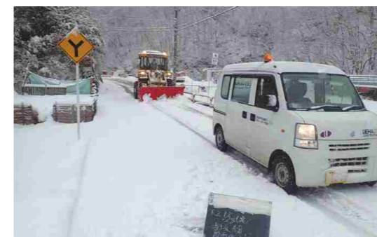
道路の除雪作業
