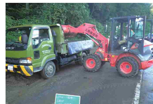
崖崩れ復旧作業
