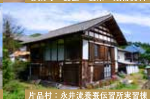
片品村：永井流養蚕伝習所実習棟
