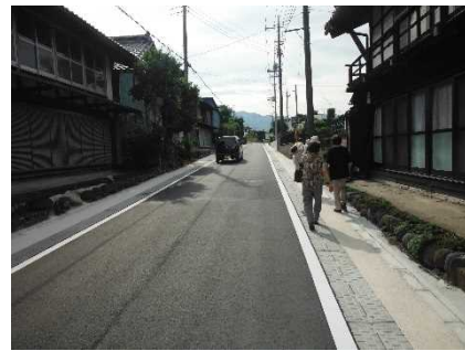
完成後の状況
