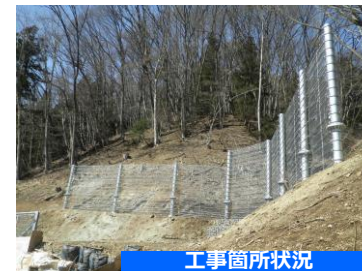
工事箇所状況
