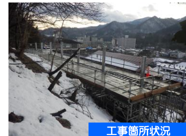
工事箇所状況
