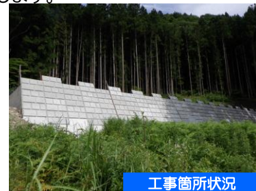
工事箇所状況
