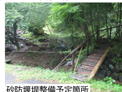
砂防堰堤整備予定箇所
