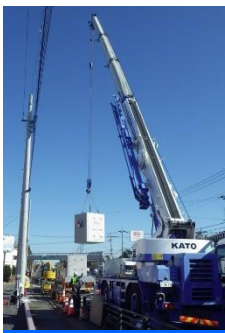
現在の工事状況
