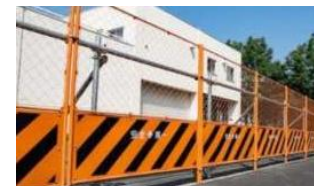
解体工事(仮囲いの設置)
