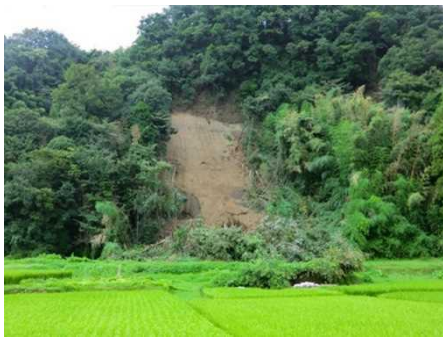
崩落した竹林
