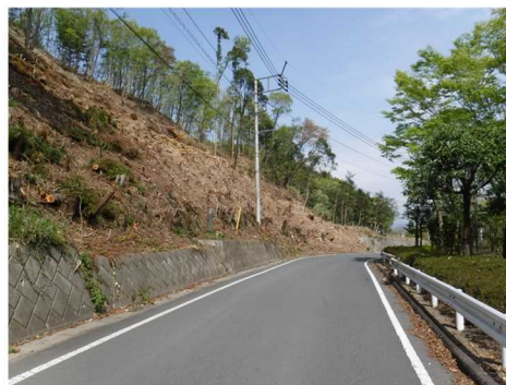
災害時の停電を未然に防止するため被害発生の危険性が高い箇所の事前伐採
