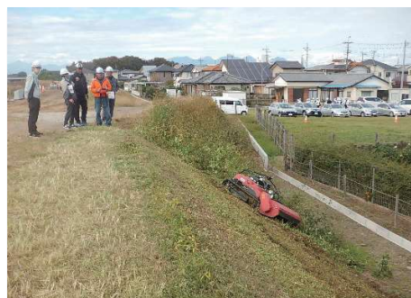
堤防のり面の施工状況
