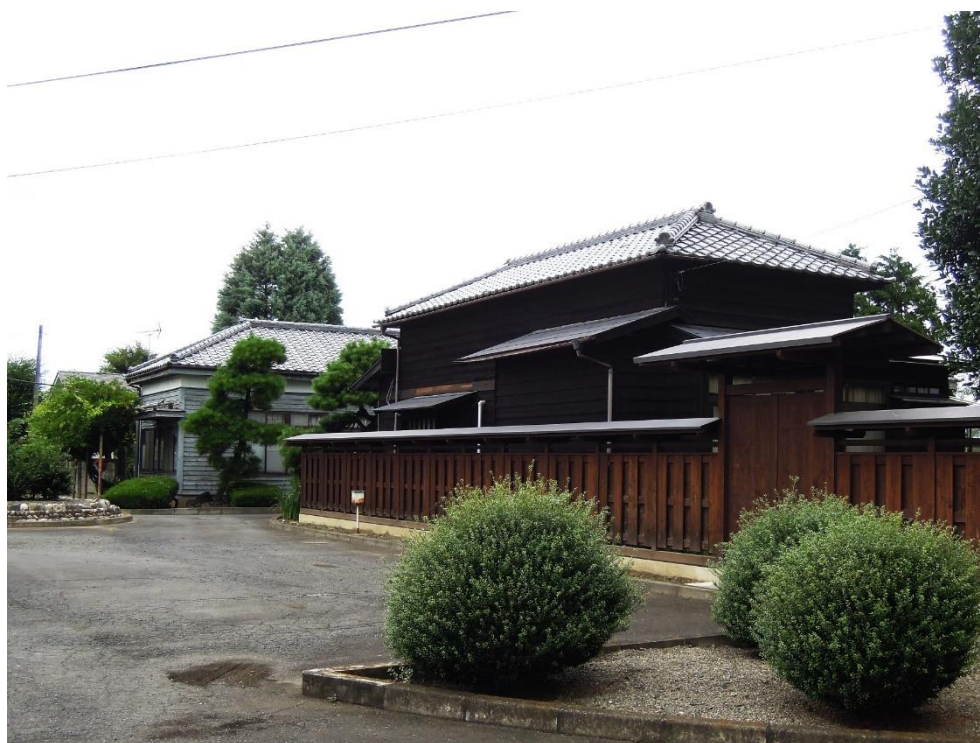
日本化薬株式会社高崎クラブ（旧岩鼻火薬製造所集会所） 外観
