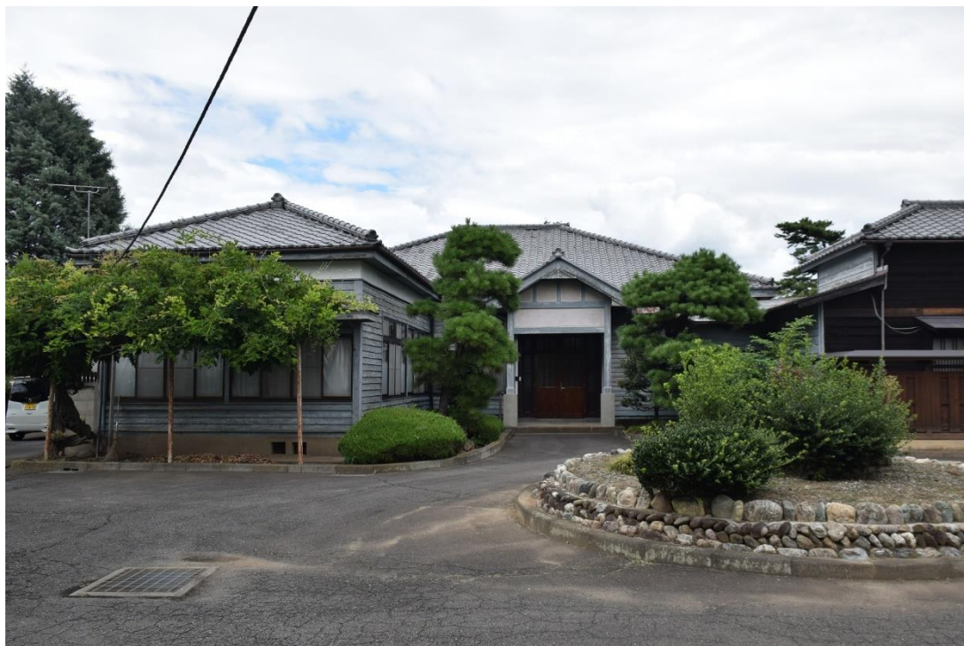
日本化薬株式会社高崎クラブ（旧岩鼻火薬製造所集会所） 玄関正面
