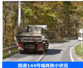
国道144号幅員狭小状況
