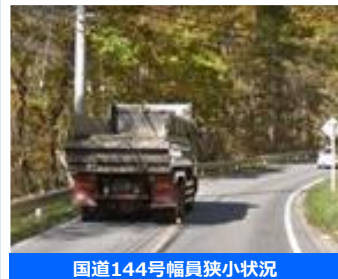
国道144号幅員狭小状況
