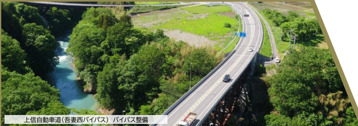
与喜屋沢 土石流対策
