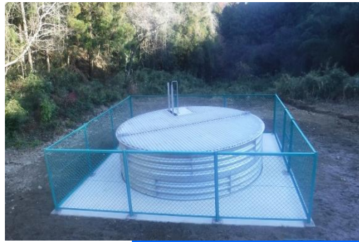
集水井A-1の完成状況 (R3.3)
