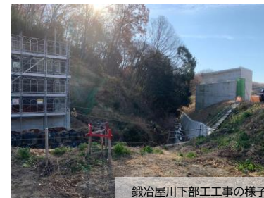
鍛冶屋川下部工工事の様子
