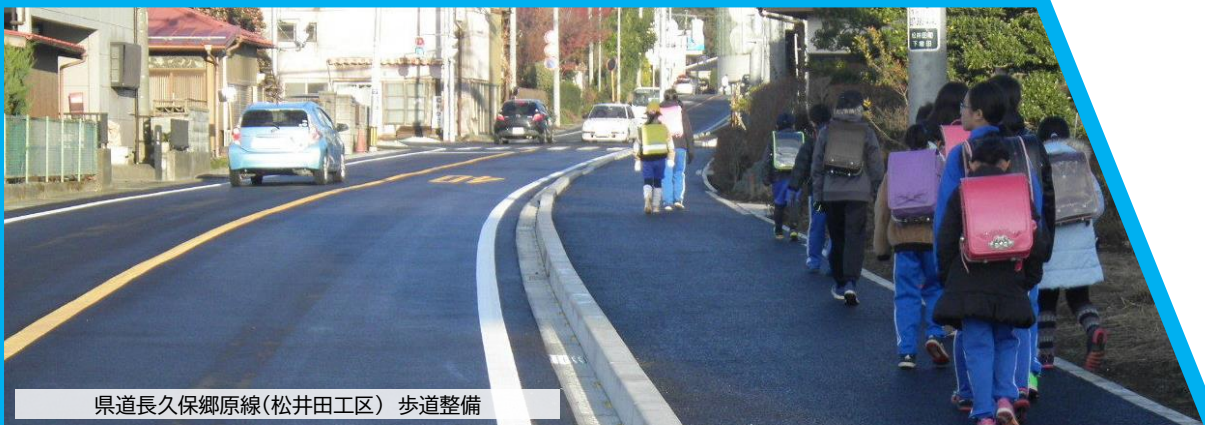
西毛広域幹線道路(安中工区) バイパス整備
