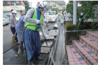
● 側溝の汚泥の除去
