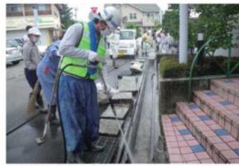
● 側溝の汚泥の除去
