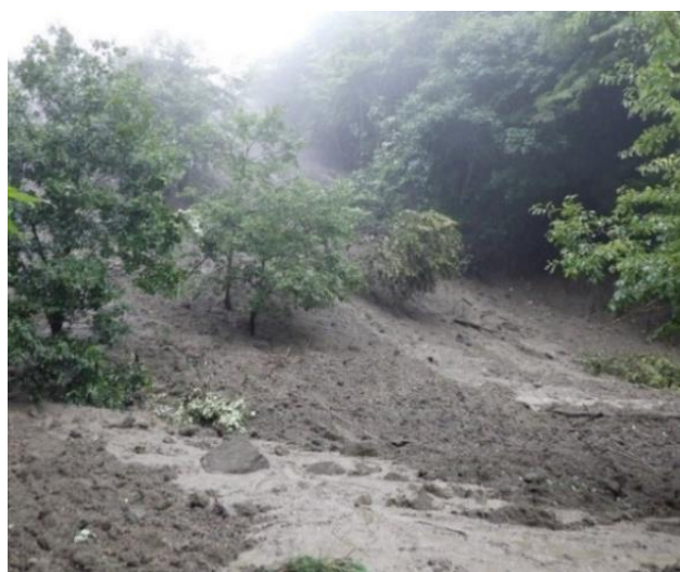
安定しない盛土のため亀裂が多く、豪雨時には浸食による流出が見受けられました。
