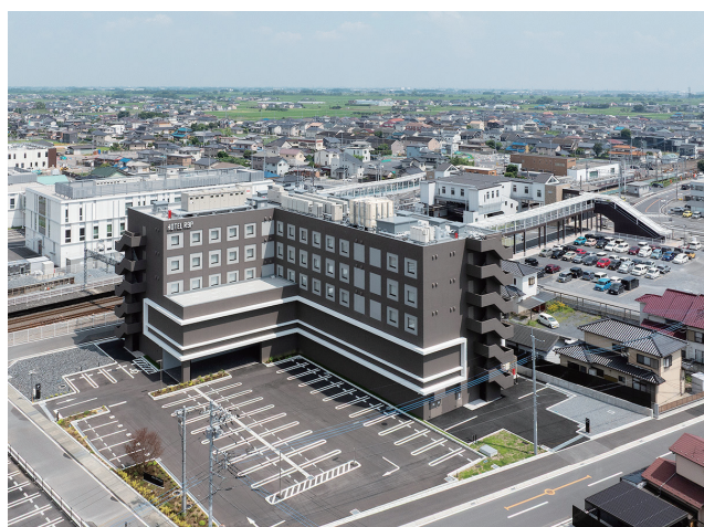
ペDESTリアンデッキで各施設をつなぐ
