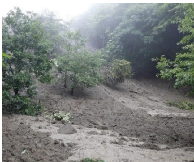
土砂の流出状況【R6.8.30撮影】
