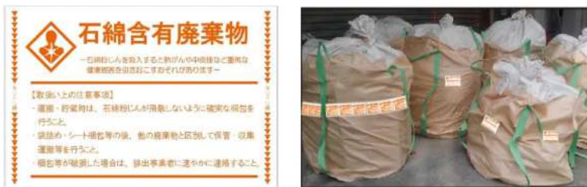
図3-7 石綿含有廃棄物の表示テープ
