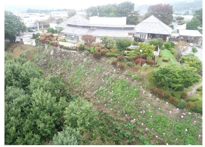
吹付法砕工から自然斜面補強土工法へ変更した箇所
