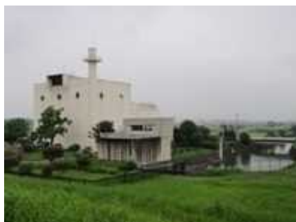
休泊川排水機場全景
