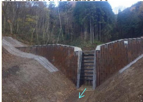
1号堰堤の完成状況
