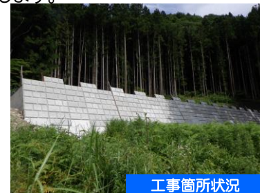
工事箇所状況
