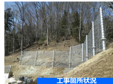
工事箇所状況
