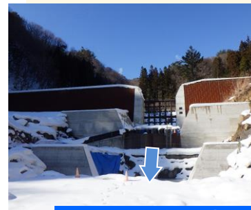
2号堰堤の前庭保護工事状況
