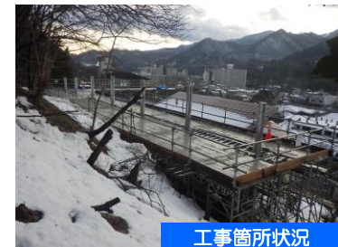
工事箇所状況
