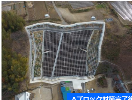
Aブロック対策完了後の状況
