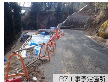
R7工事予定箇所
