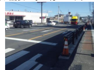
R7工事予定箇所
