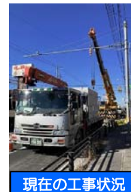
現在の工事状況
