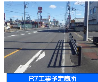
R7工事予定箇所
