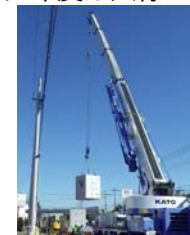
現在の工事状況
