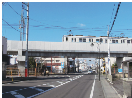
■ 高架化により除却された踏切
