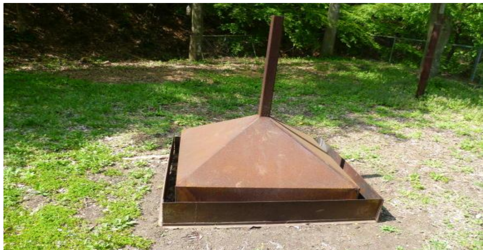
清掃後の煙突フードと風除け鉄柵
