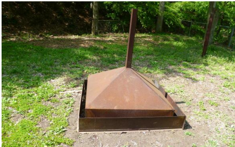
清掃後の煙突フードと風除け鉄柵
