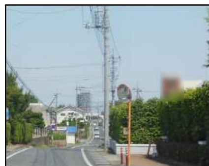
＜通行を妨げる電柱状況＞ （伊勢崎市太田町）
