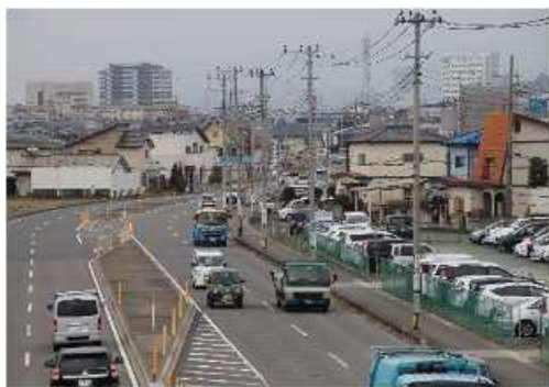
新設B Pにおける電柱占用状況 県道 25 号 高崎渋川線
