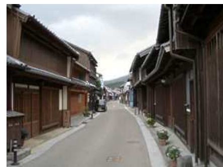
屋側配線方式の整備事例 <三重県亀山市関町> ※国土交通省 HP より
