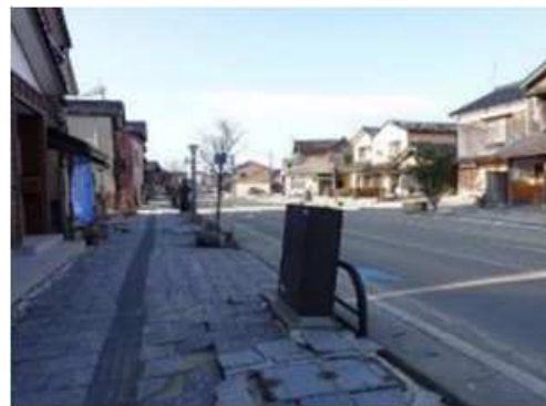
地上機器の傾き（輪島市） 国土交通省 「無電柱化の推進に関する 取組状況について」より
