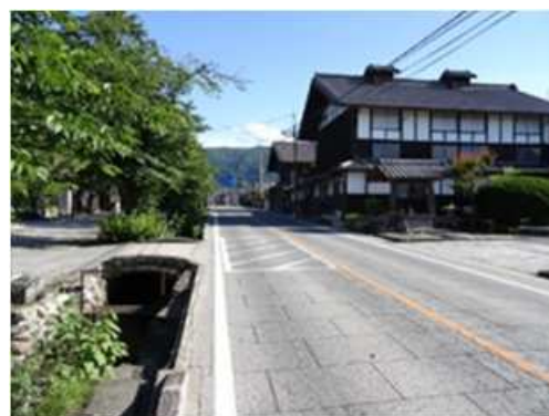
歴史的風致維持向上計画における重点区域 である小幡地区の電柱や電線の状況
