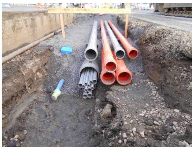
【 電線共同溝の施工状況 】
