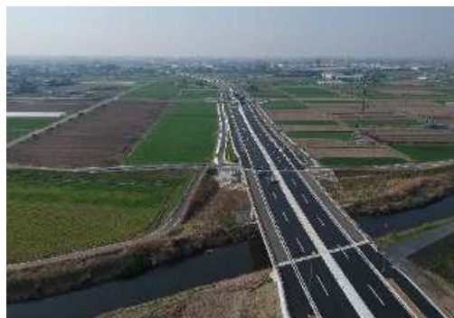
新設B Pで電柱占用が無い状態 国道 122 号
