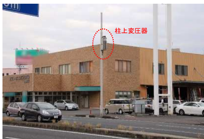
【ソフト地中化の整備事例（国道17号）】
