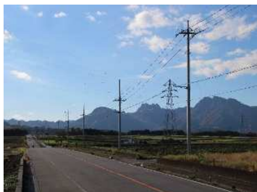
電柱や電線による妙義山の風景の妨げ 県道 47 号 下仁田安中倉漕線
