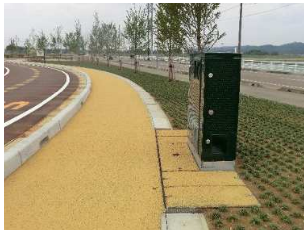
【 小型ボックス構造の整備事例 】
