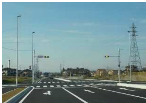
交差点部の上空横断線を無くした事例 国道 122 号
