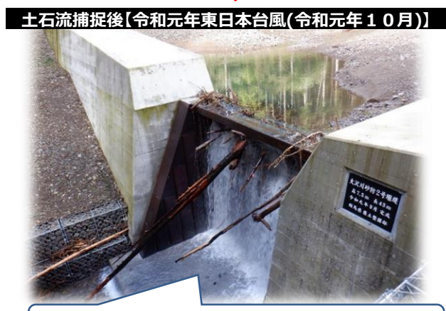
堰堤完成からわずか1ヶ月後に土石流を捕捉
