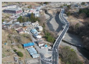
(国)299号 神流町神ヶ原地内 古鉄橋上流工区(R5完成)
