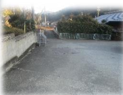
避難経路（町道）
