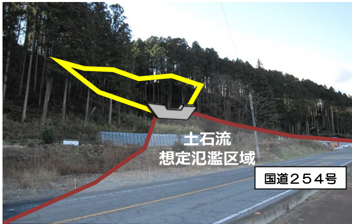
土石堆積状況
