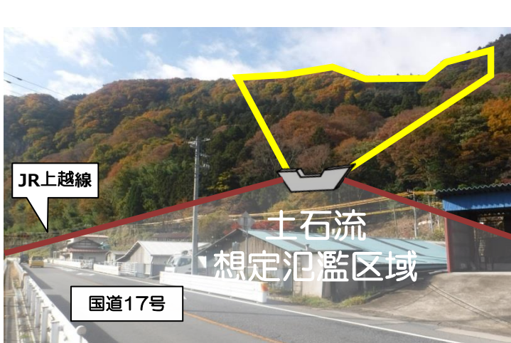
土石堆積状況
