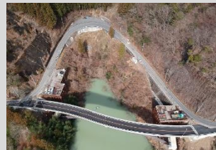
(国)462号 藤岡市坂原地内 坂原工区[琴平大橋] (R1完成)
