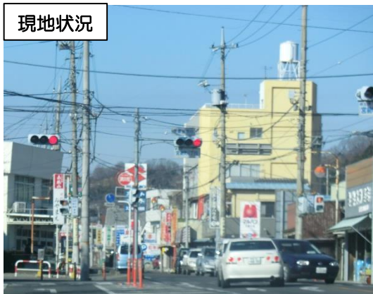
乱立する電柱・電線類
