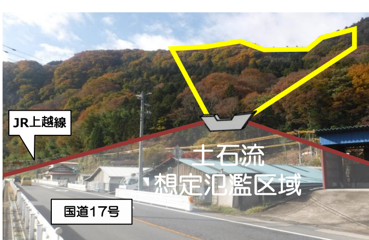
土石堆積状況
