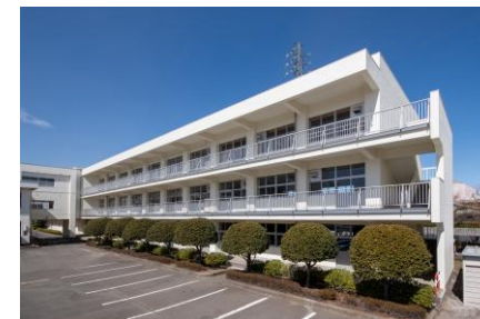
改修工事を行った県立学校
