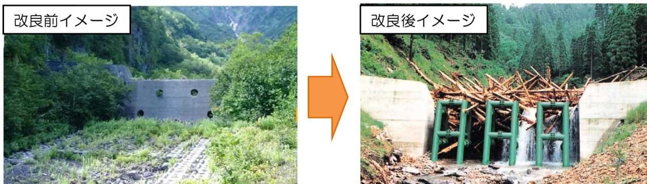
写真 14 既設砂防堰堤の流木対策イメージ
