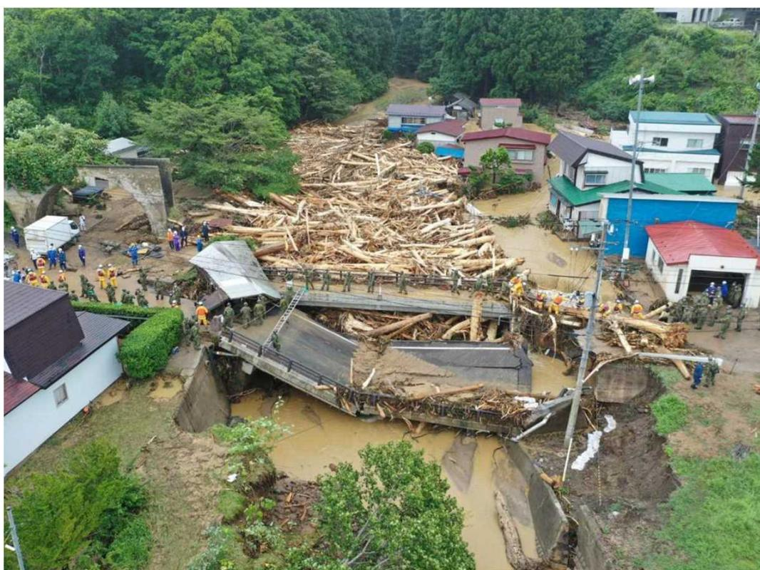
写真 9 流木による河道の閉塞
