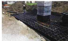
写真 雨水貯留槽（地下埋設）
