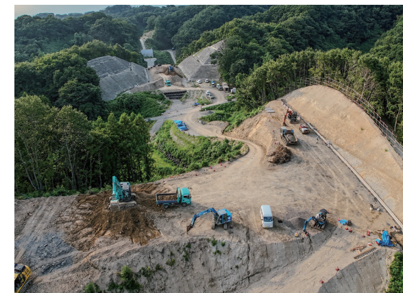
ICT活用工事現場
