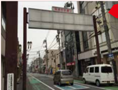
撤去されずに残されたアーチ看板
