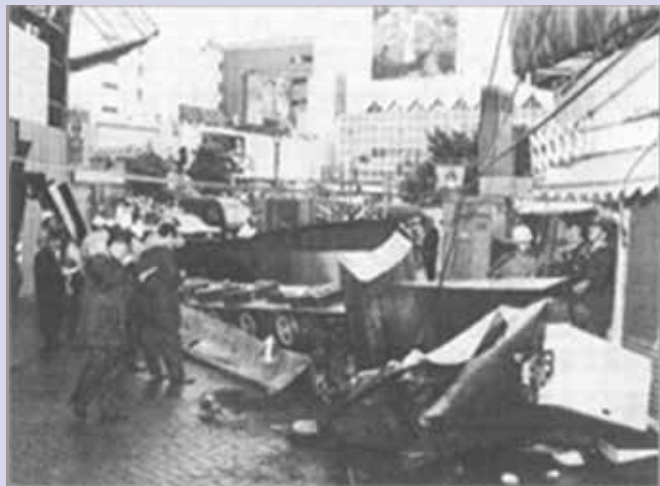
台風で落下した時の様子
