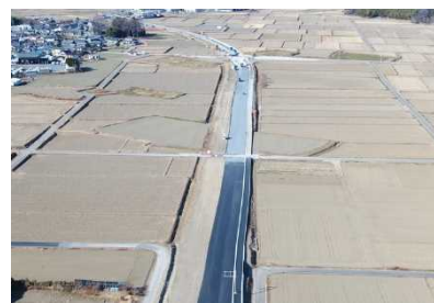
バイパス整備中の状況【令和7年2月撮影】
