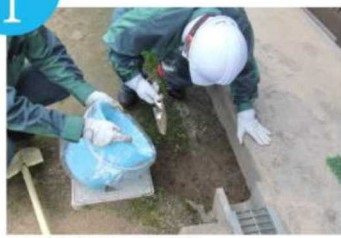
● 民家の軒下・雨樋の清掃
