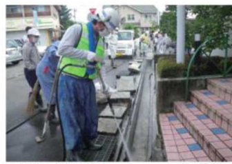
● 側溝の汚泥の除去
