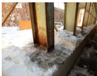
鋼材の腐食
