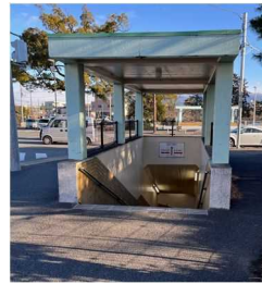
(主)前橋安中富岡線 中央地下歩道
