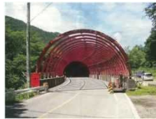
湯檜管スノーシェルター
