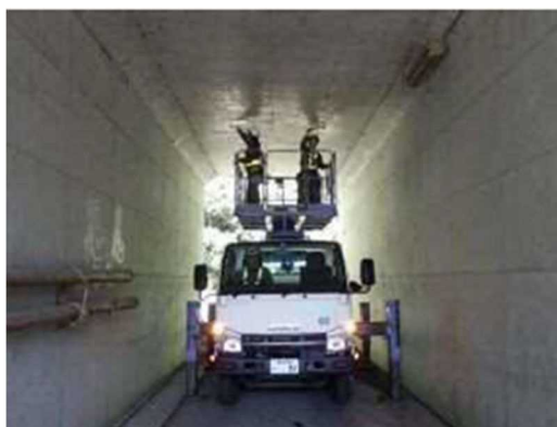
＜近接目視によるカルバート点検状況＞
