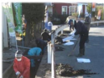
水路の泥上げ
