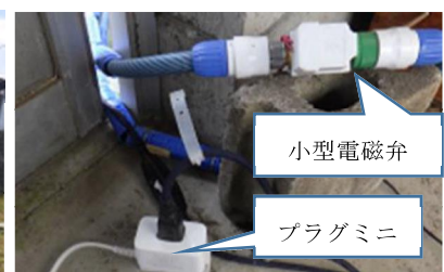
図－３ プラグミニと小型電磁弁
