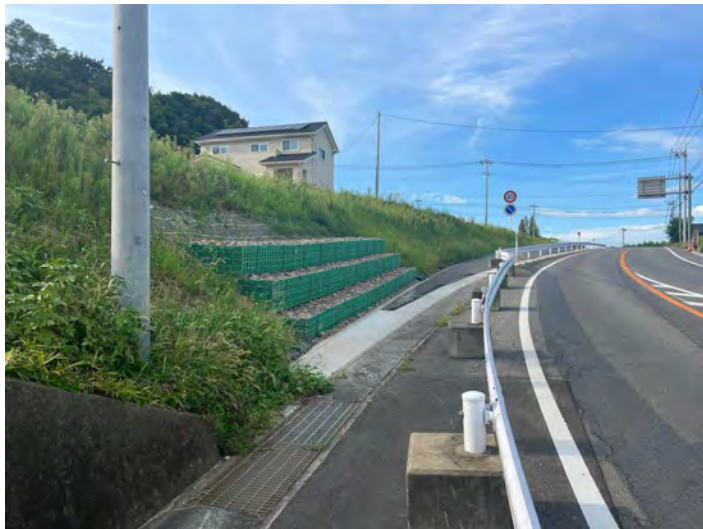
令和4年度単独道路改築事業 後賀工区 分割2号
