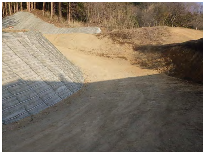
令和5年度社会資本総合整備 (防災・安全)(通常砂防)(5ヶ年)
