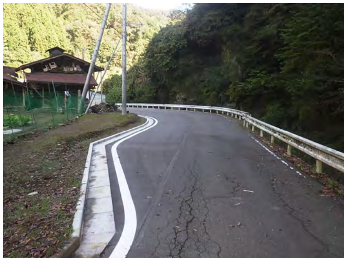
令和4年単独道路改築事業 小塩沢・黒滝工区
