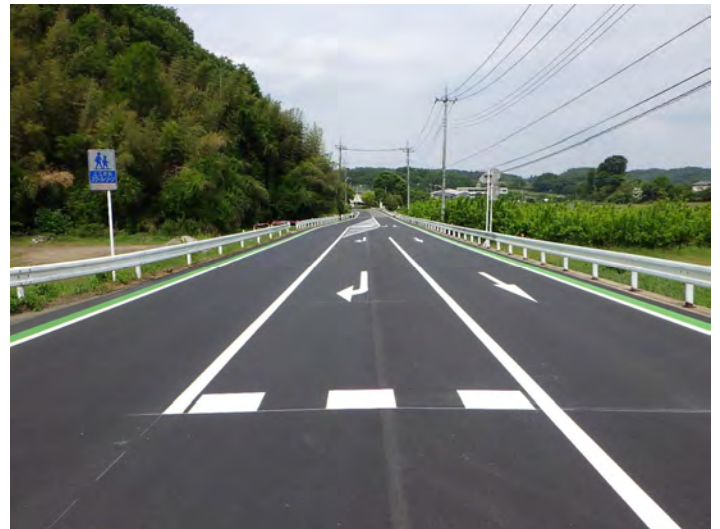
令和4年度単独道路維持修繕事業 (舗装(適管債)) 原工区
