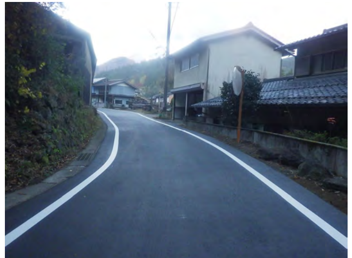
令和5年度単独道路維持修繕事業 (舗装(適管債))
