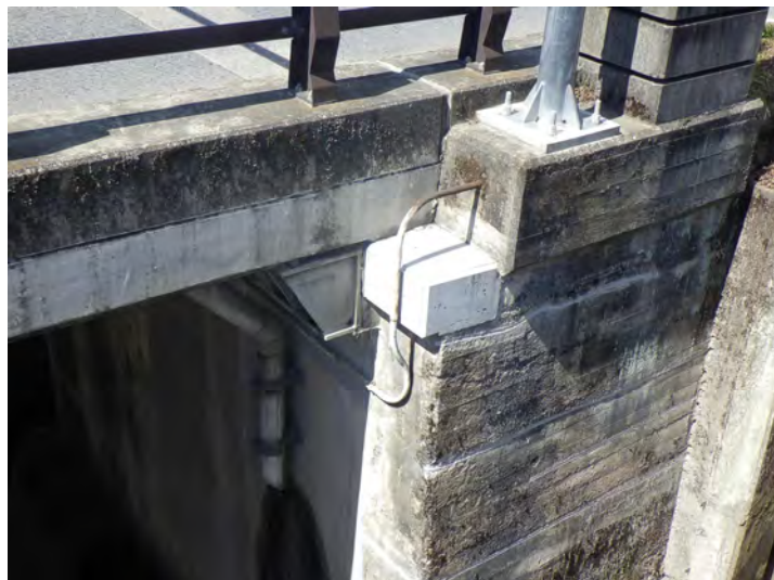
令和4年度道路メンテナンス事業(橋梁) 石湍橋(上下線)
