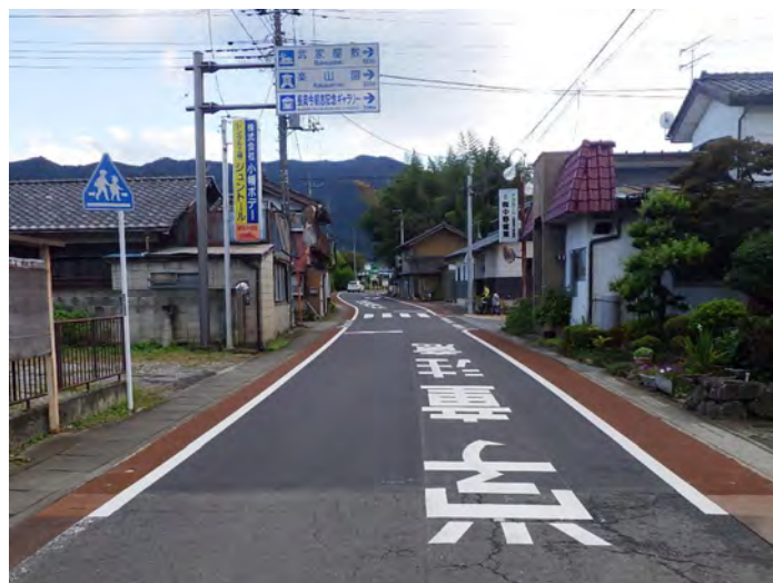
令和5年度単独道路維持修繕事業 (舗装(適管債)) 小幡工区
