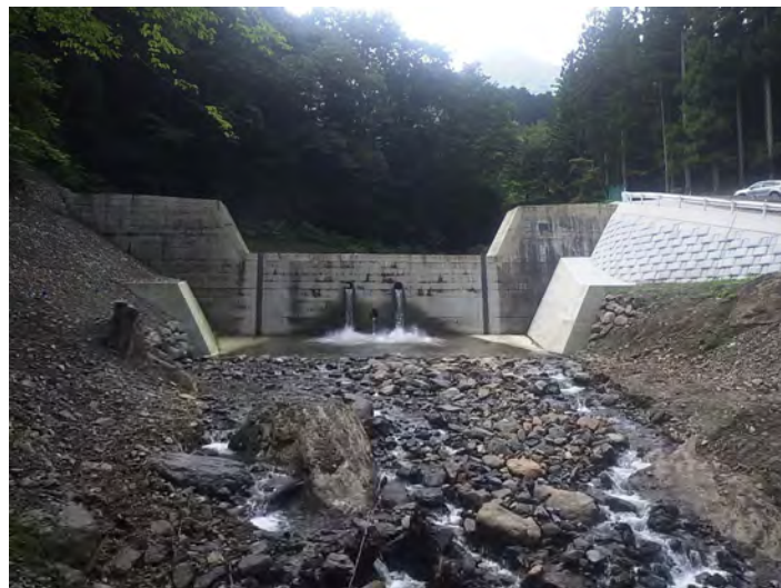
令和4年度社会資本総合整備 (防災・安全)(緊急改築)(5ヶ年)
