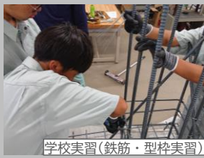
学校実習(鉄筋・型枠実習)
