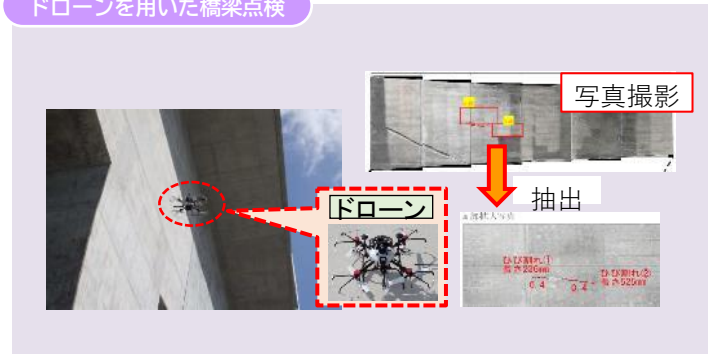
ドローンを用いた橋梁点検
