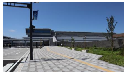
景観に配慮した舗装や照明((都)コンベンション施設北口線)
