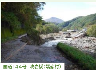
国道144号 鳴岩橋(婦恋村)
